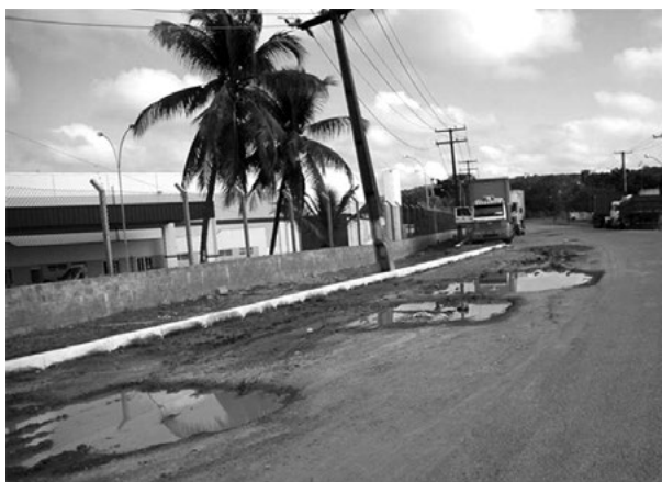
Figura 2 Estado da pista no distrito industrial
